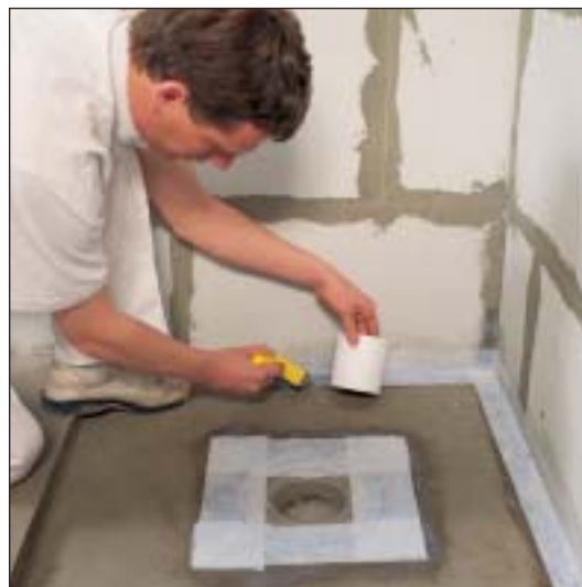
Montering af armeringsvæv med LIP Vandtætningsbinder
