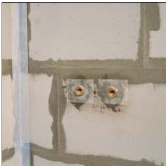
Armering ved rørgennemføring
